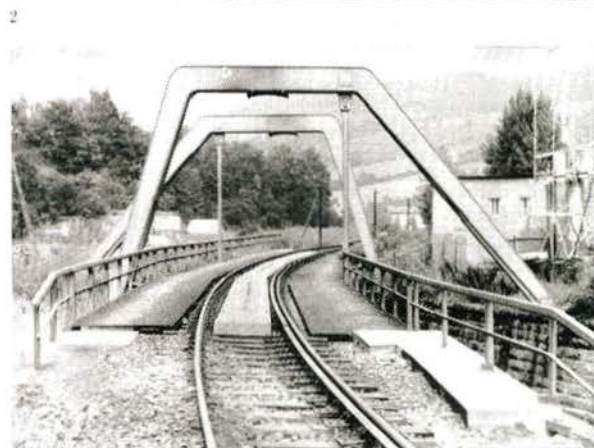
Bild 1 Die Überführung über die Gottleuba, bachaufwärts gesehen Bild 2 Der Blick in die Gegenrichtung Bild 3 Und so sieht die Durchfahrtsöffnung aus
