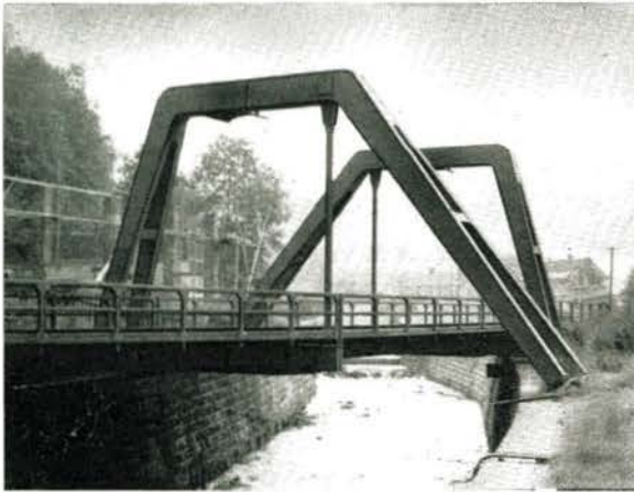
Bild 5 Ausführung der Portalrahmen
