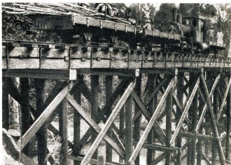
Bild 3 Brücke über den Mongamba
