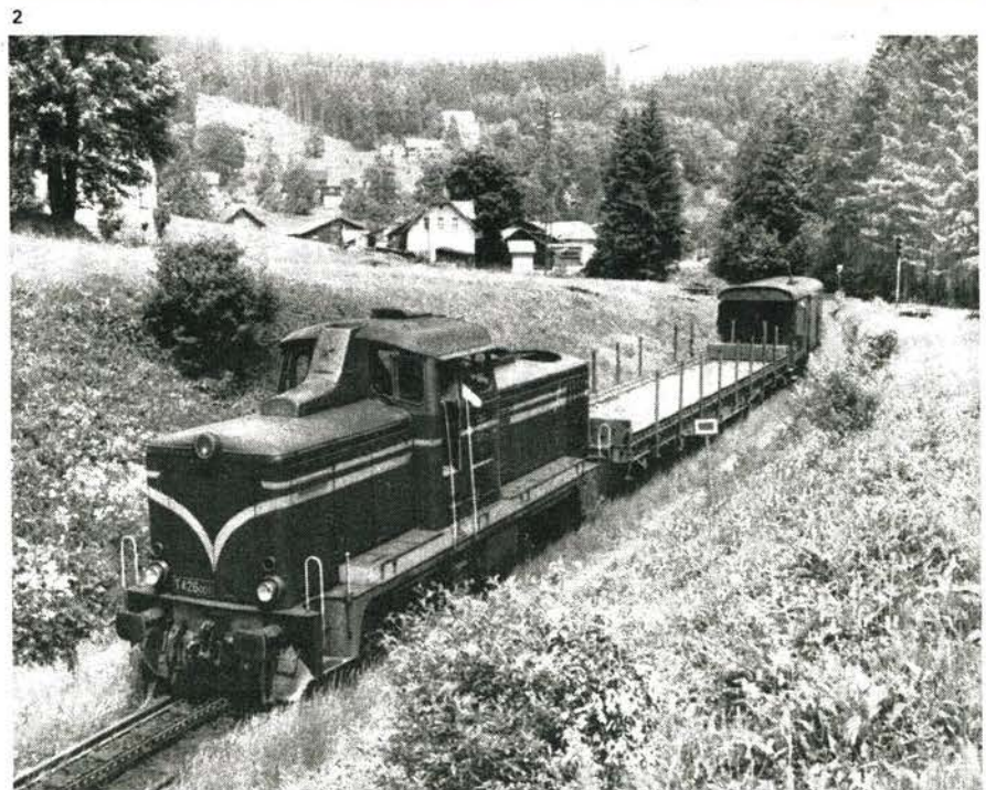
Bild 1 Der Triebwagen M 240.0109 hat soeben den unterhalb des Bahnhofes Dolni Polubny liegenden Tunnel verlassen.
