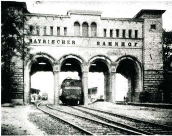
Bild 1 Der Portikus des EG im derzeitigen Zustand
