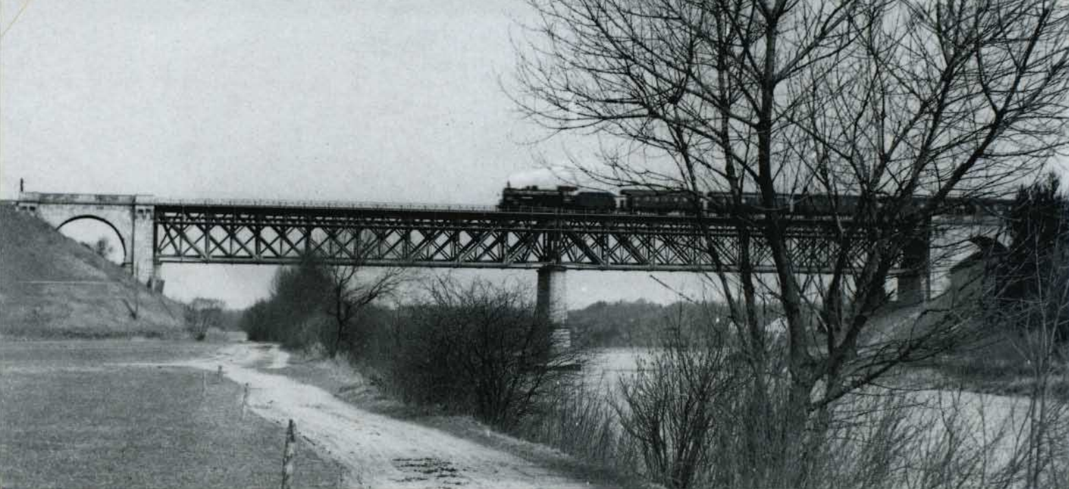
Bild 8: Am 12. April des Jahres 1935 entstand diese Aufnahme. Sie zeigt die Brücke über den Lech bei Kaufering der Strecke München – Buchloe. Eben überquert ein Personenzug mit einer Lokomotive der Baureihe 38 10 dieses Bauwerk. Foto: Rbd Augsburg
