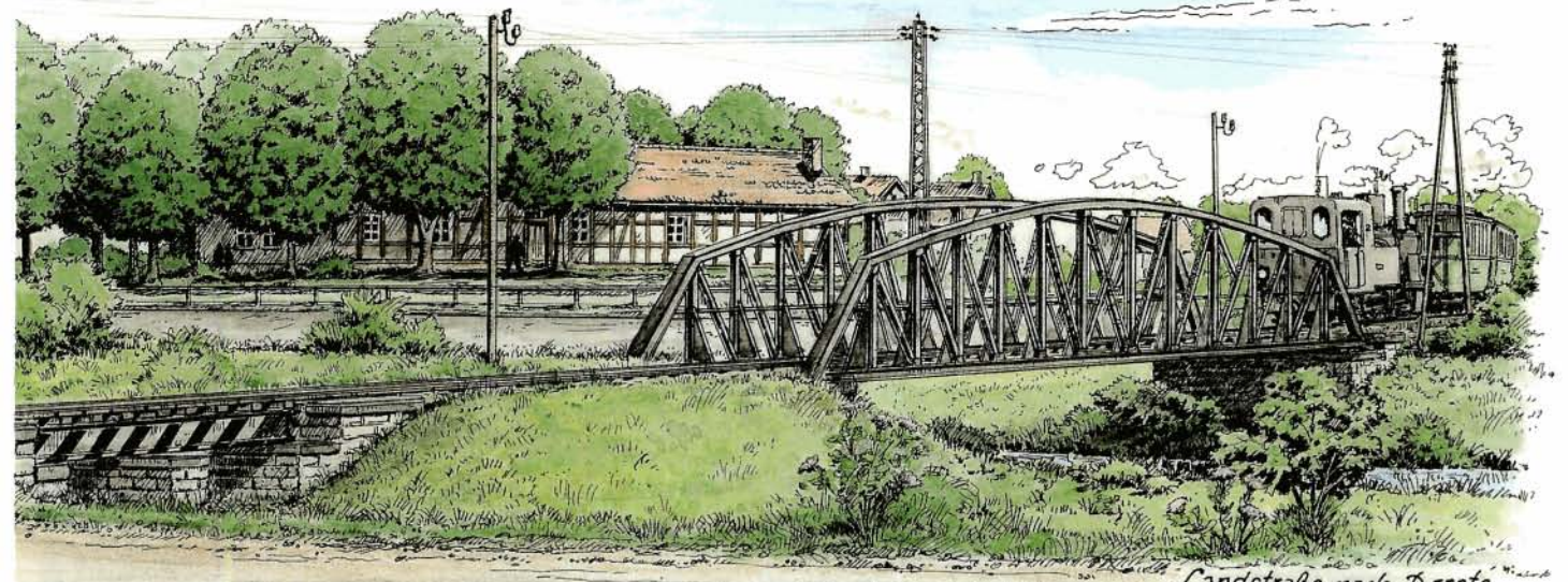
② Bahnübergang und Sösebrücke bei Förste
