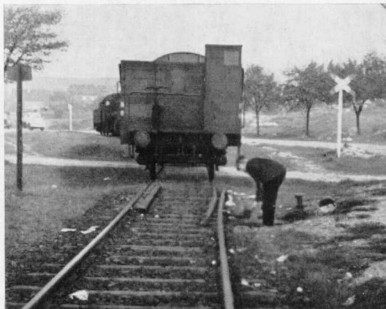
Blickrichtung bergab. Entgleisungszunge wird nach Passieren des Zuges sofort wieder umgestellt.
