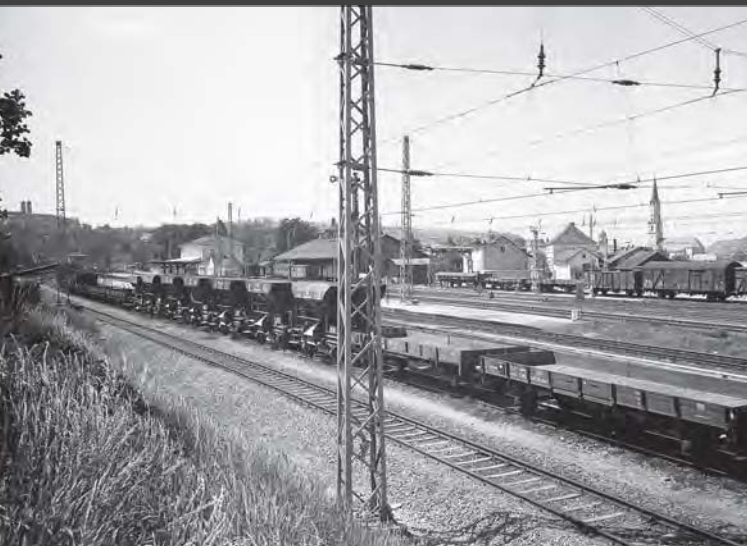
Links: Ostansicht des Bahnhofs Vilshofen unmittelbar nach Abschluss der Elektrifizierungsarbeiten. Foto: Paul Fuchs, Slg. Maier
