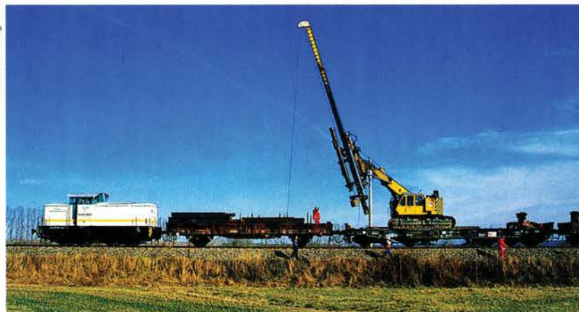
KEG-Lok 003 am 3.3.1997 mit Bauzug zwischen Oberröblingen und Voigstedt.
