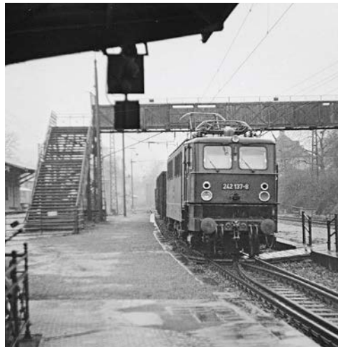
68 Anno 1976 passiert 242 137 Bad Kösen samt Fußgängersteg über die Gleise. Heute zeigt sich die Station ziemlich gewandelt
