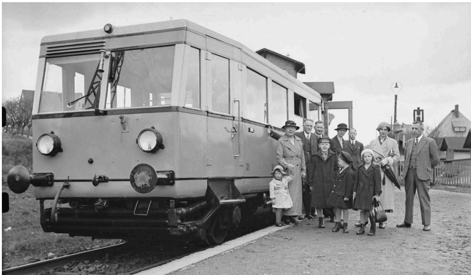
Der ab Werk mit einem Imbert-Generator ausgerüstete VT 31 der Kleinbahn Bielstein-Waldbröl behielt seinen Holzgas-Generator bis nach dem Zweiten Weltkrieg, das heißt, mehr als zehn Jahre; das war deutscher Rekord! Ende der 1930er-Jahre diente er im Kleinbahnhof Waldbröl als Kulisse für dieses herrliche Familienfoto. Gut zu erkennen sind die unter dem Wagenkasten umlaufenden Rohre zur Kühlung und Reinigung des Gases. Der Generator befindet sich am anderen Wageneende links neben dem Führerstand
