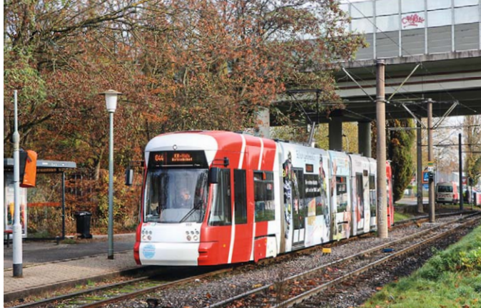
Krefeld: Tw 660 hat unter der Autobahnbrücke gerade hinter der Wei-che zum eingleisigen Streckenstück Richtung Bahnhof Linn gewendet und rollt jetzt an die Haltestelle Rembertstraße
