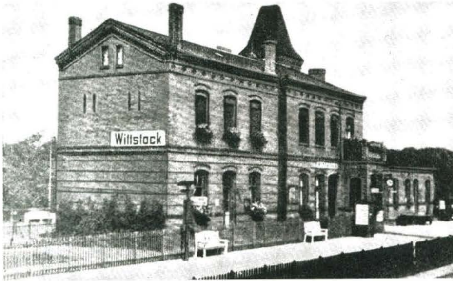
Bild 3 Das ursprüngliche Aussehen des Bahnhofs Wittstock
