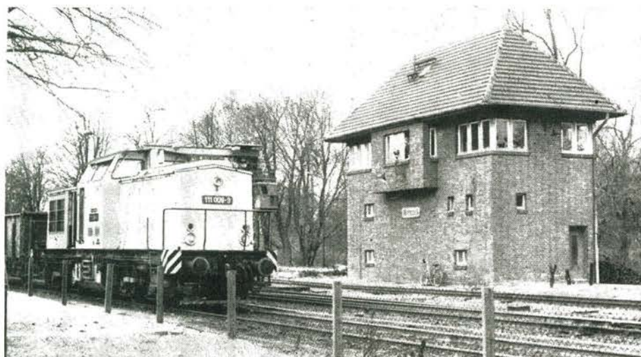
Bild 6 Stellwerk in Wittstock (Dosse), ebenfalls 1938 in Betrieb genommen. Der Bahnhof erhielt zu diesem Zeitpunkt elektrische Bahnhofsblockeinrichtungen. Im Vordergrund die Diesellokomotive 111 008. (1982)
