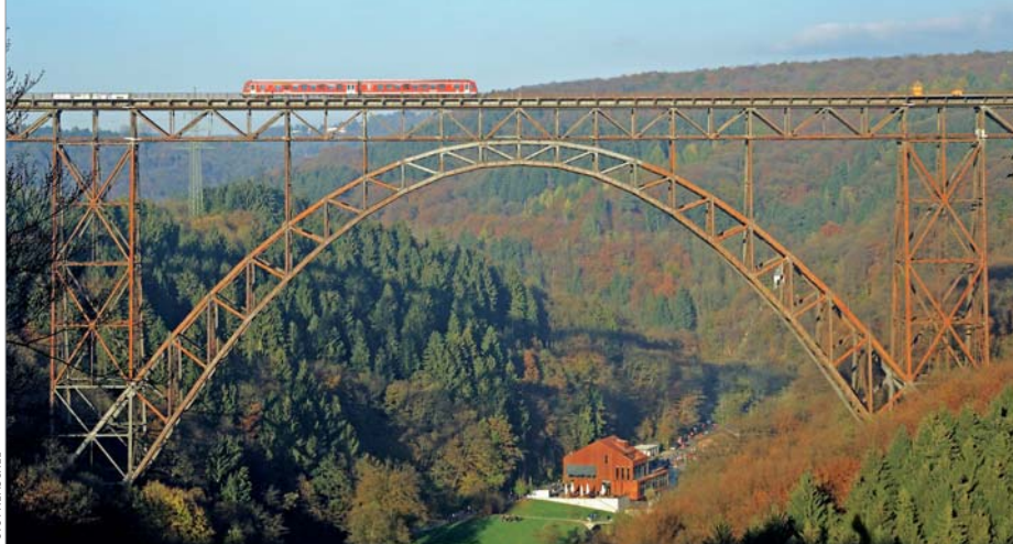
Ein 628-Triebzug überquert als RB47 am 28. Oktober 2012 die arg in die Jahre gekommene Müngstener Brücke bei Solingen-Schaberg.
