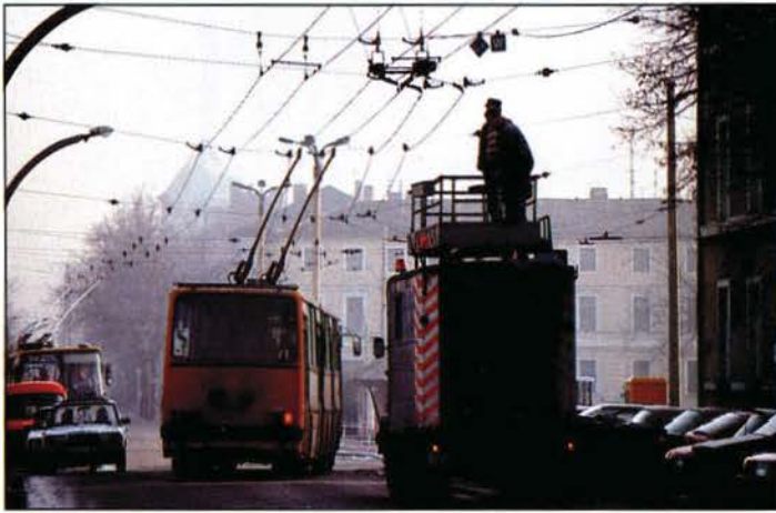
Während am 7. Januar 1992 in Weimar ein klappbarer H3A-Fahrleitungsmontagewagen zur Reparatur einer unweit vom Hauptbahnhof befindlichen Weiche genutzt wird ...
