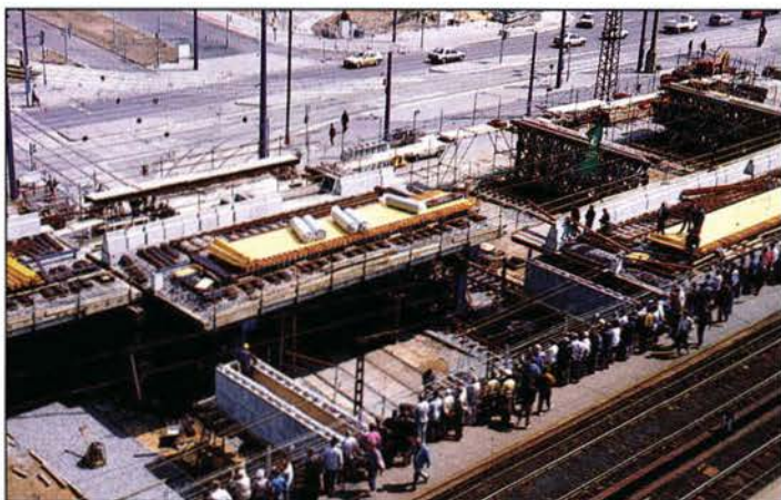
Aus gleicher Perspektive wie oben, zeigt dieses Foto eine weitere Phase des Brückenverschubs. Deutlich sichtbar hat sich der Überbau aus der Montageachse bewegt.
