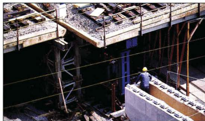
Der Beginn des Querverschubs im Detail. Hier wird noch einmal die Größe des Unternehmens deutlich: 450 Tonnen werden in Schrittgeschwindigkeit bewegt.
