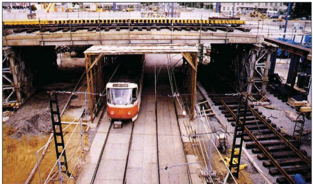
Eine der Hauptforderungen an den bauausführenden Ingenieurbetrieb Dresden ist die Aufrechterhaltung des Straßenbahnbetriebes auch während der Bauarbeiten.
