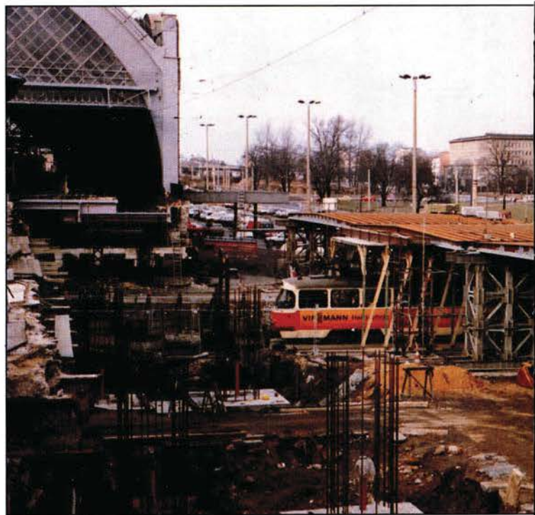
Das Bild vom 7. Februar 1992 zeigt die Vormontage der neuen Brückenfelder. Noch sind die T mit Beton vergossen. Die Behelfsunterstützungen sind eine Konstruktion der RBD Erfurt.
