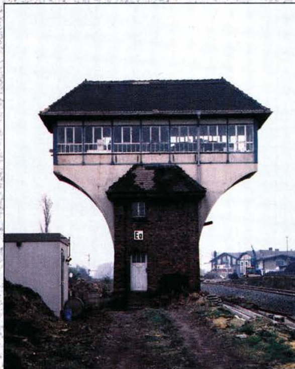
Wo am 7. Mai 1992 noch der Stil des Pilzstellwerkes in Eisleben stand, verläuft acht Wochen später das neue Hauptgleis.
