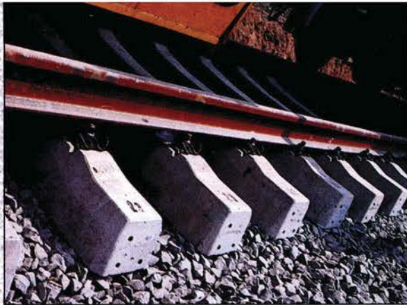
Die Verlegemaschine bringt Schwellen für Schwellen auf den Schotter, richtet sie seitlich und im Abstand aus und fädelt schließlich die Fahrschiene auf die Befestigungsplatte. Die Federklammern werden erst später festgeschraubt.
