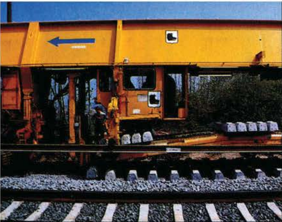
Die Verlegemaschine bringt Schwellen für Schwellen auf den Schotter, richtet sie seitlich und im Abstand aus und fädelt schließlich die Fahrschiene auf die Befestigungsplatte. Die Federklammern werden erst später festgeschraubt.
