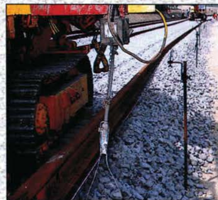
Das Vorausfahrzeug des Gleisbauzuges UP 4 formt den Schotterdamm und nimmt die Fahrschienen auf. Gelenkt wird der tonnenschwere Koloß automatisch und zentimetergenau von dem zuvor sorgsam eingemessenen Steuerseil.
