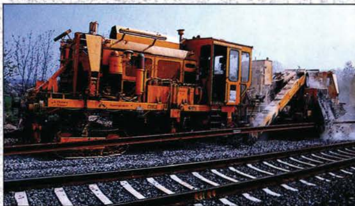
Das Vorausfahrzeug des Gleisbauzuges UP 4 formt den Schotterdamm und nimmt die Fahrschienen auf. Gelenkt wird der tonnenschwere Koloß automatisch und zentimetergenau von dem zuvor sorgsam eingemessenen Steuerseil.
