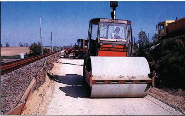
Das Planum (Mutterboden, Kies, Frostschutzmischung) wird so stark verdichtet, daß selbst schwere Lkw keine Spuren hinterlassen. Von der Frostschuttschicht wird das Niederschlagswasser in die seitliche Drainage abgeleitet.
