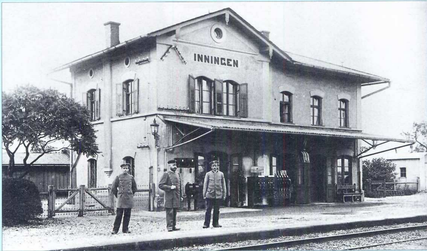
Bild 4: Um 1900, als dieses Foto entstand, verfügte auch der Bahnhof Innungen (südlich von Augsburg) bereits über eine kleine zentrale Stellwerkanlage.
