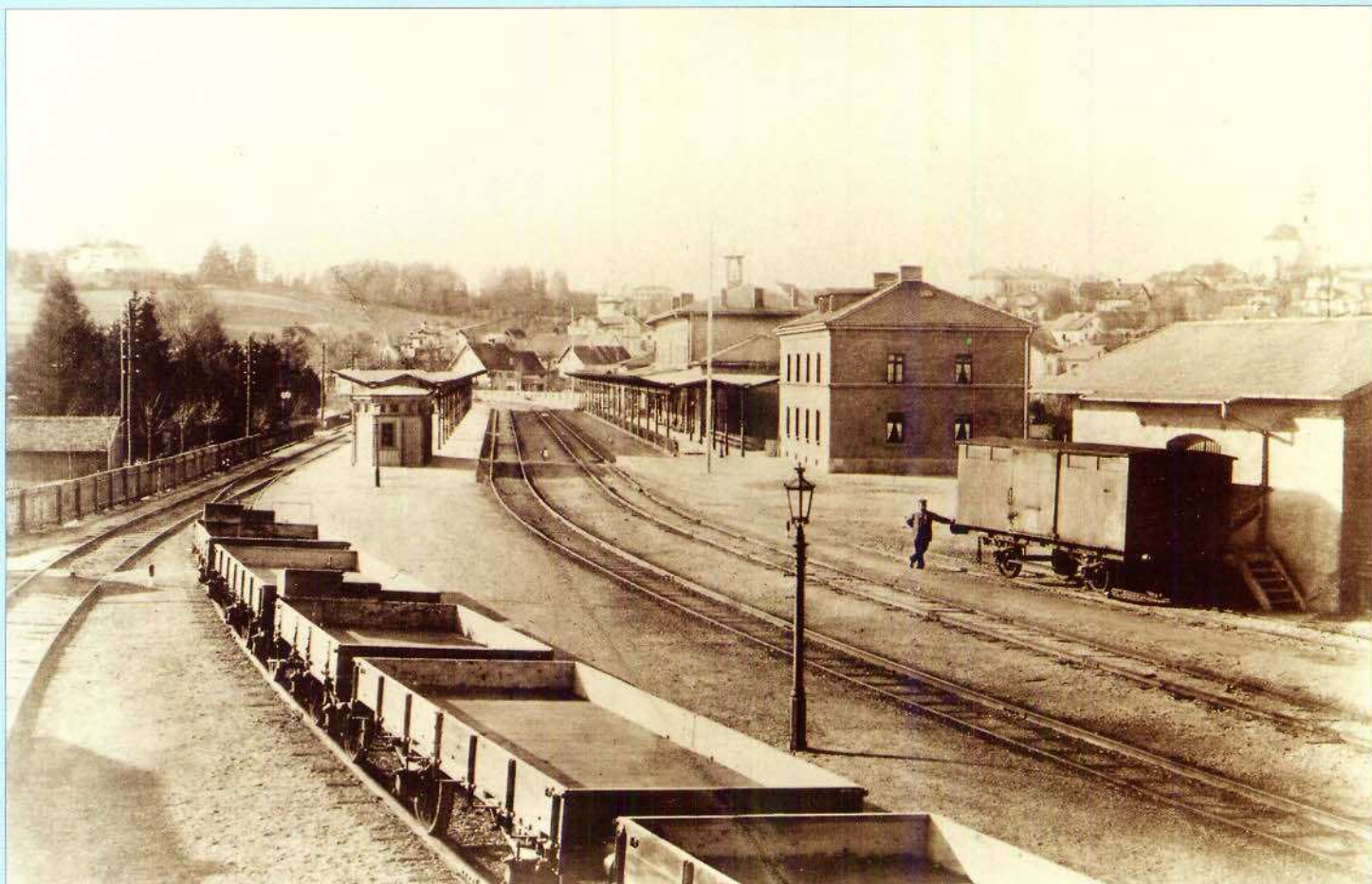
Bild 3: Im Bahnhof Sarnberg war vor 100 Jahren noch jede Menge Platz. Der See grenzt links unmittelbar an das Bahnhofsgelände. Abb.: VM Nürnberg
