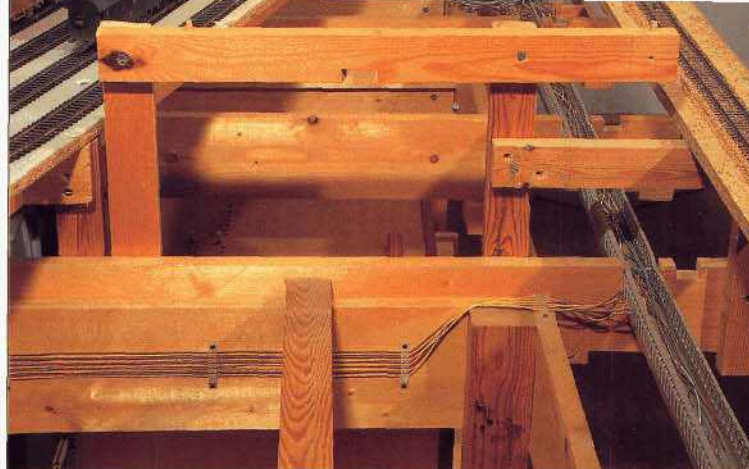
Bild 11: Die Bestandteile des solide ausgeführten Unterbaus: Längs- und Querträger sowie Auflagerträger für den Bahnhofsbereich.
