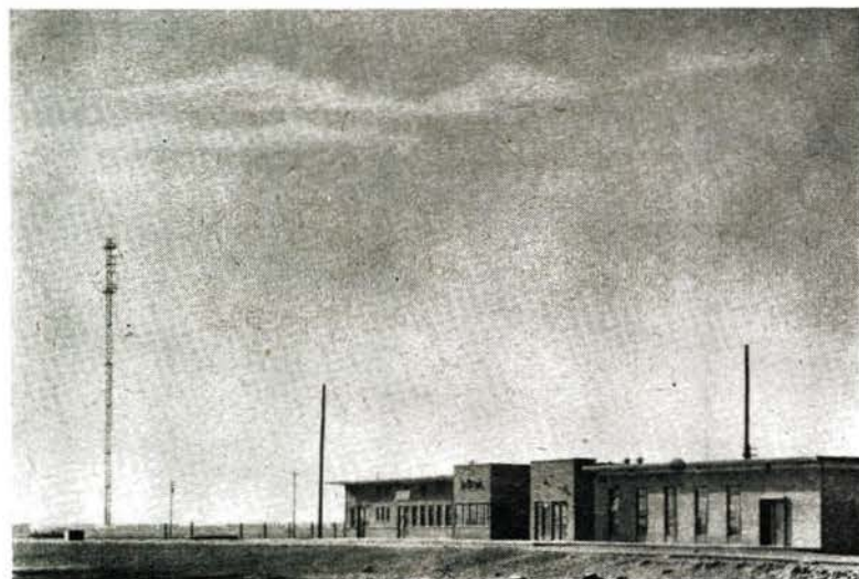
Bild 3 Richtstrahl-Station Riad, unmittelbar an den Eisenbahngleisen gelegen
