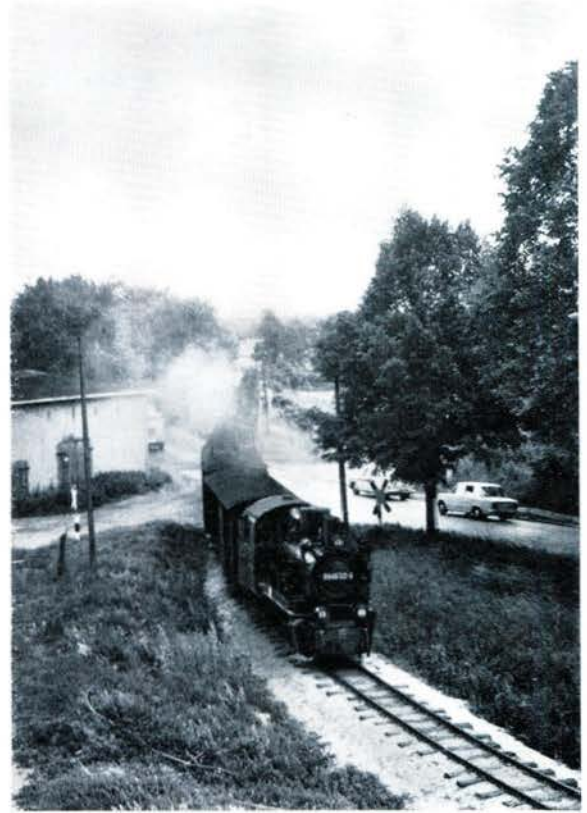
Bild 2 Und hier in Sellin am Wegübergang.
