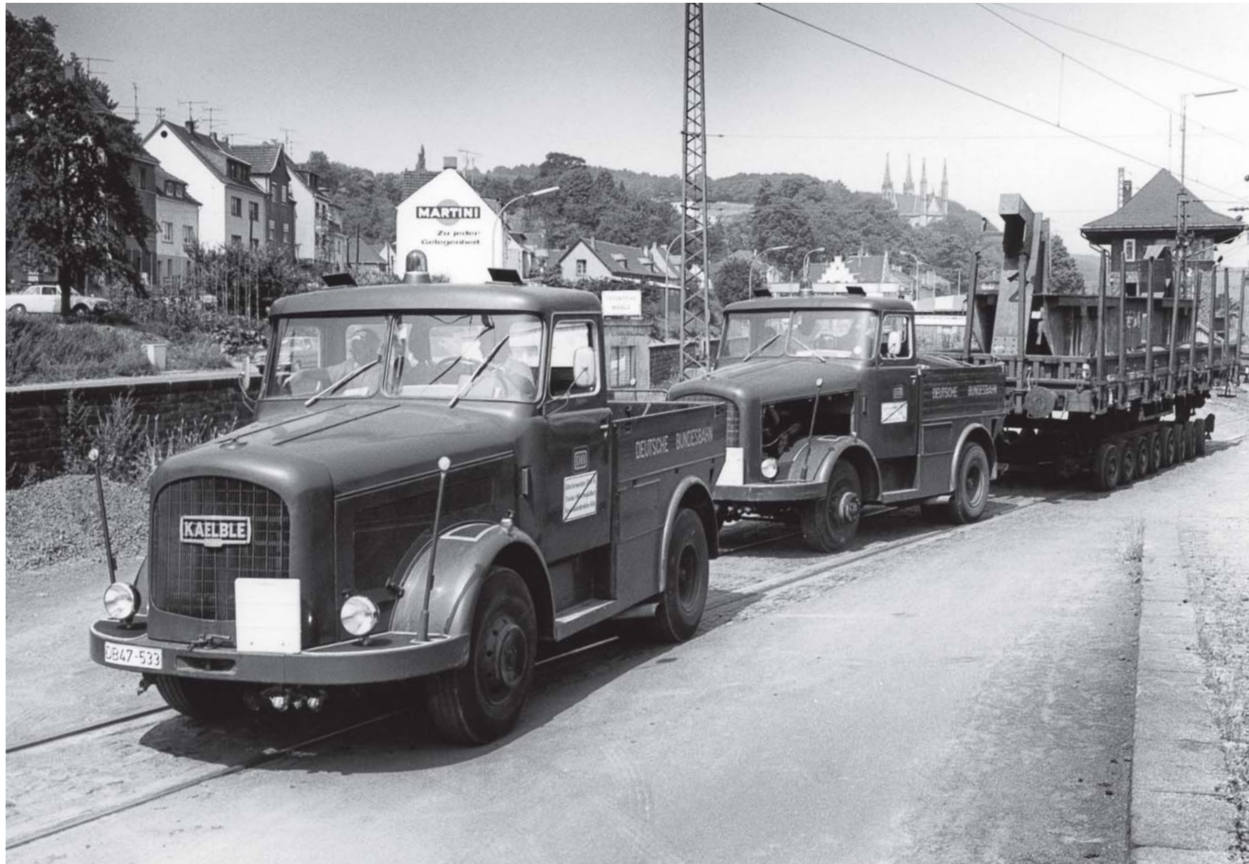
Stahlteile für den Bau der Autobahntalbrücke Bengen an der heutigen Autobahn A 61 (Bauzeit 1971 bis 1975, Freigabe 18. Dezember 1975) wurden vom Bahnhof Remagen aus per Straßenroller zugeliefert. Da auf schmalen Landstraßen erhebliche Steigungen aus dem Rheintal heraus zu bewältigen waren, spannte man gleich zwei Kaelble-Zugmaschinen vor. Foto: Filmstelle/Zentrales Bildarchiv der DB
