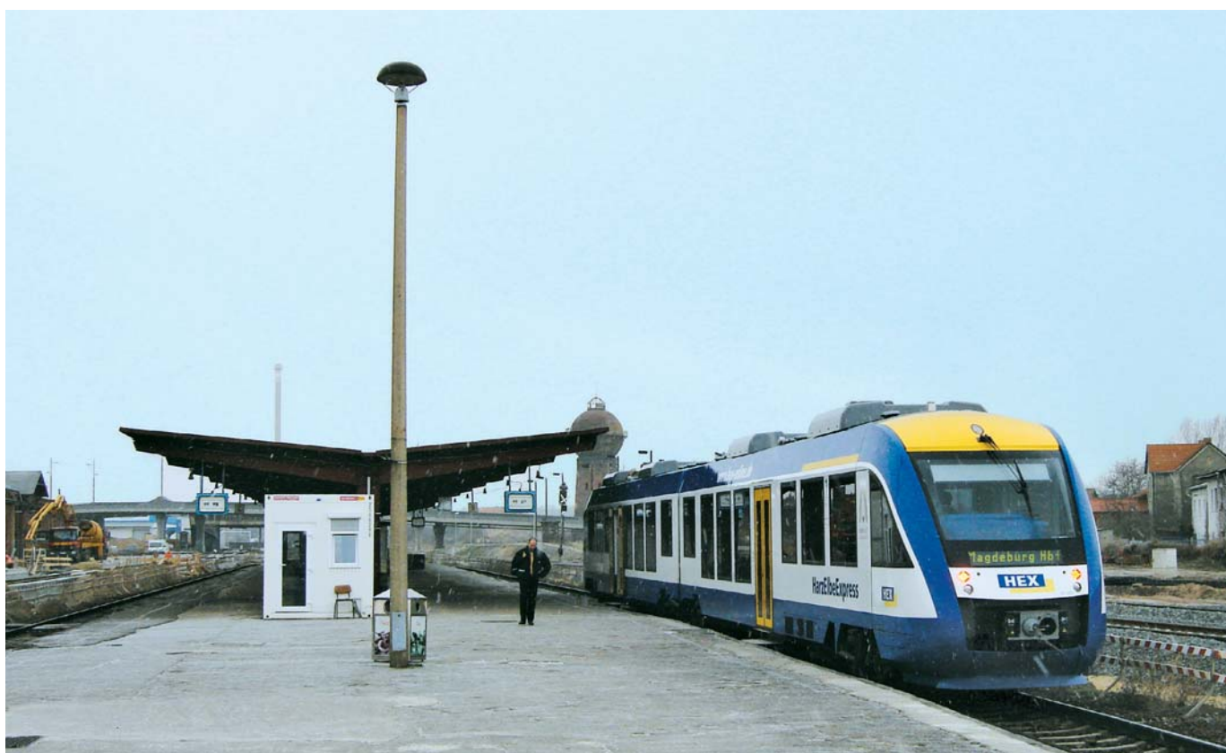
Eine große Baustelle ist zurzeit der Bahnhof Halberstadt, an dem bei leichtem Schneefall am 22. Februar 2007 der HEX von Halle nach Magdeburg steht.
