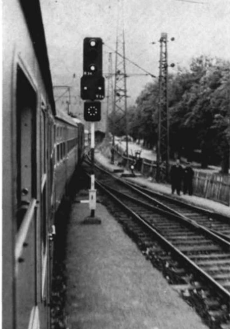
Abb. 9. Ein Signalkuriosum besonderer Art: Österreichisches Haupt- und Versuchs-signal am gleichen Mast mit einem deutschen Zusatzsignal Zp 9 (Abfahrbeauftrag) — fotografiert im Bahnhof Kufstein von Herrn Ing. Oskar Schneider, Wien.
