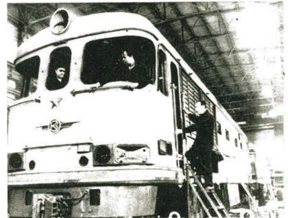
Bild 3 Ganz jungen Datums ist diese neue Diesellok, die auch über 4000 PS verfügt. U. B. z. einen Blick in die Endmontage der „Kuibyschew“-Werke in Kolomna.
